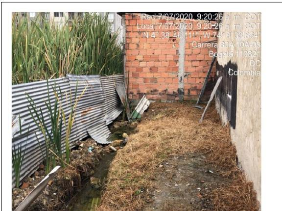
Fotografía No. 2. Cerramiento predio CHIP AAA0148KUNX, Tejas de zinc, compactación del suelo, RCD.
