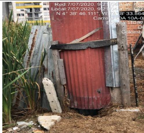
Fotografía No. 3. Cerramiento predio CHIP AAA0148KUNX, Tejas de zinc, compactación del suelo, RCD.
